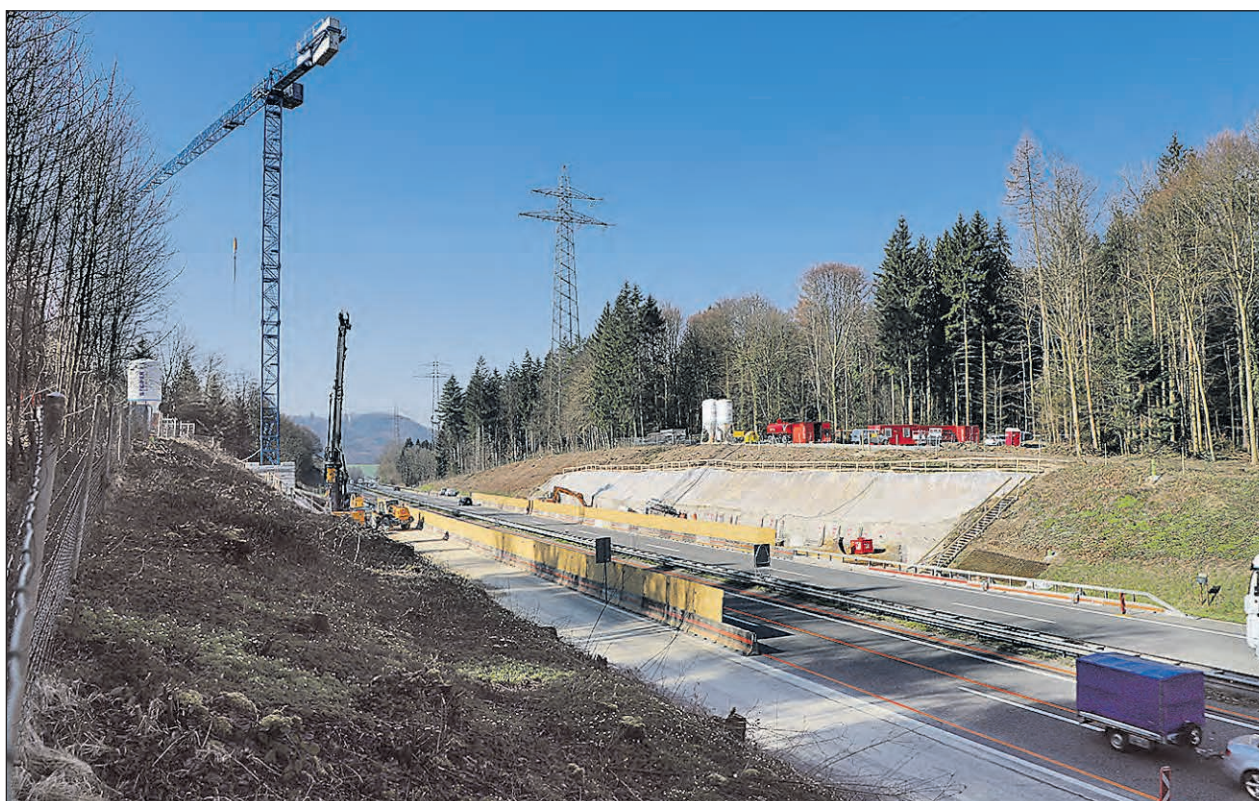
Die Vorarbeiten für den eigentlichen Brückenbau sind fast abgeschlossen. Autofahrer auf der A1 fahren an dieser Stelle bald durch einen Tunnel aus Holzträgern.
